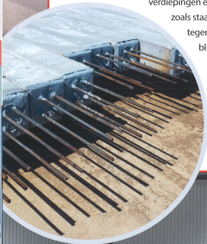
met staal versterkte betonbalken
